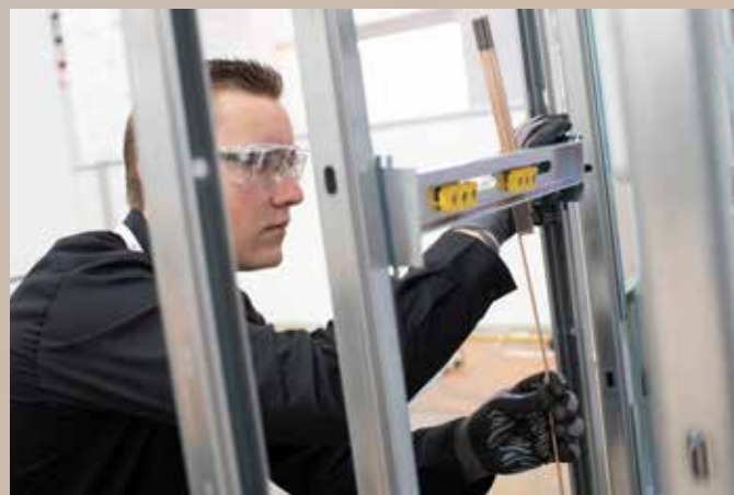
Alexander Kilian, Seewen | Sanitärmonteur EFZ
