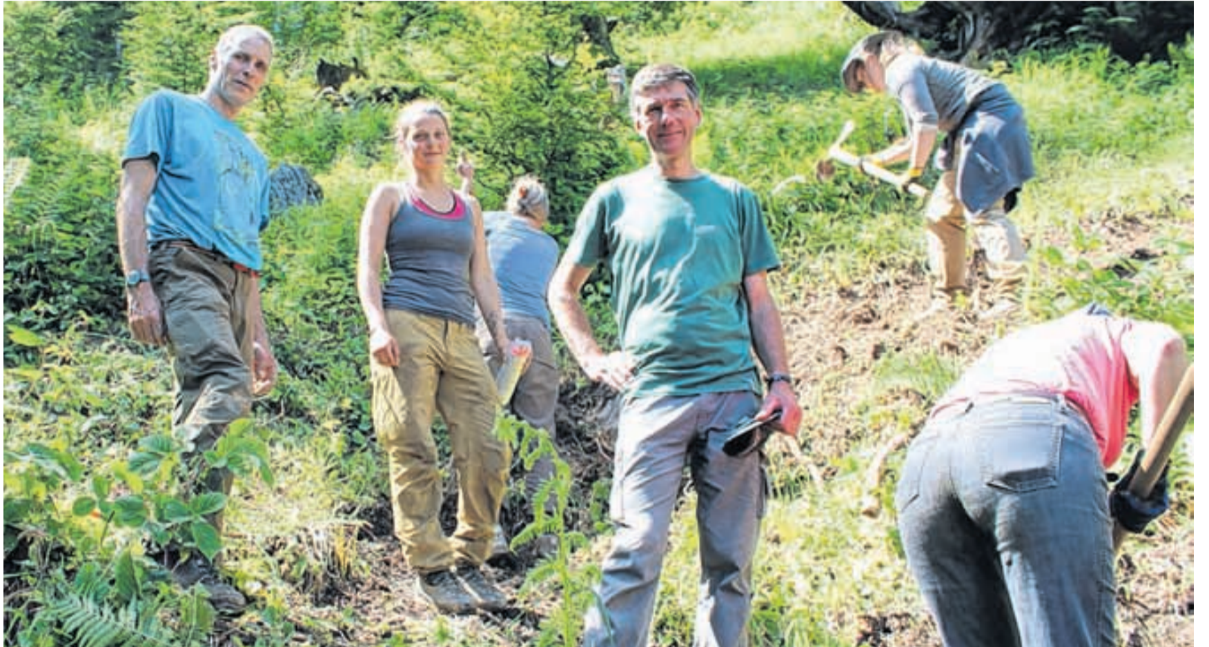
Mit Wiedehopfhauen und Steinschlegel arbeiten sich die Laien durch den steilen Wald oberhalb der Jugendherberge im Wägital. Anleitungen für den Wegbau bekommen sie vom Geschäftsführer des Bergwaldprojekts, Martin Kreiliger, Gruppenleiterin Nadine Werner und Projektleiter Jörg Eberhart (von links).
